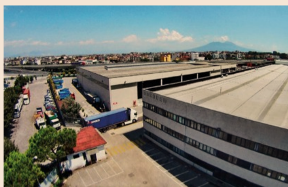
Esterno dello stabilimento
