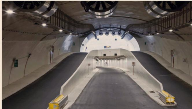
Esempio di impianti di ventilazione, illuminazione e segnaletica realizzati da SIEI in galleria
